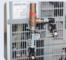
冷水回路内の圧力を必要以上に上げたくない場合に必須。
