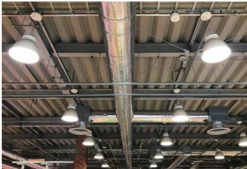
2013年10月に熊本県で開催された国連環境計画(UNEP)の外交会議で、「水銀に関する水俣条約」が採択され、日本を含む92か国が署名しました。この条約により2021年以降は水銀灯※の製造や輸出入が禁止となり、一般的な工場や倉庫、体育館など、天井が高い施設の照明に使われている高圧水銀灯(HPMV)をLEDランプへ交換する動きが加速しています。 ※HIDランプを除く
